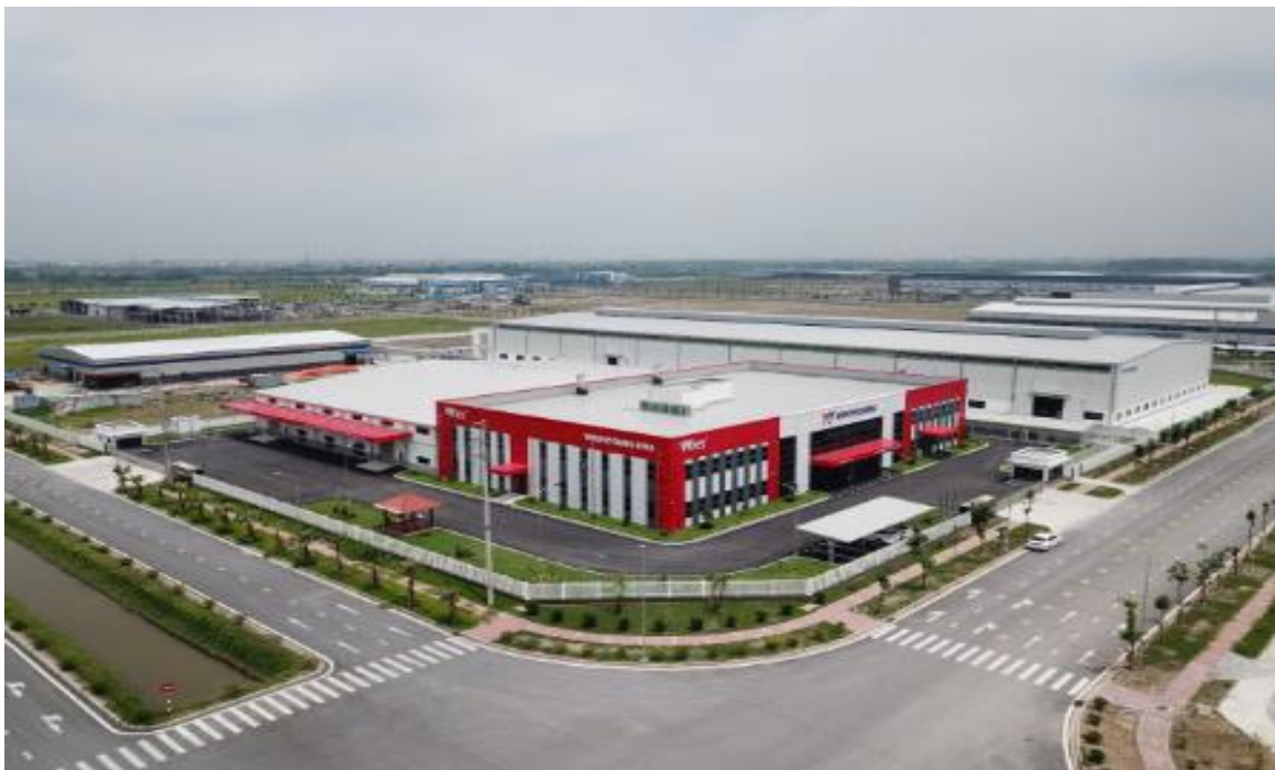
<하나건설은 베트남 흥옌성에 위치한 (유)Woonyoung Vina 프로젝트를 설계와 시공으로 완료한 건설 사업. 하나건설 제공>
